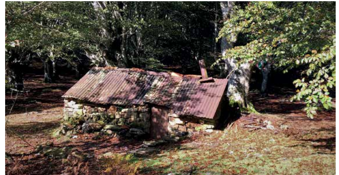
Zizkiño antes de la rehabilitación.
